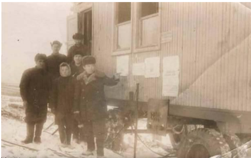
Подстанция «Макларен». Технорук Жамбалов.
