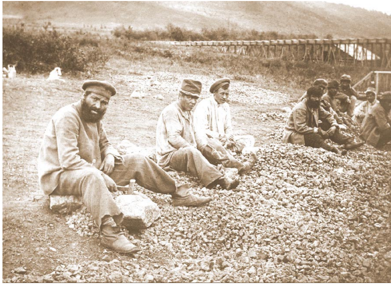
Каторжане вручную дробят щебенку для строительства Сибирского тракта. Фотография конца XIX века.
